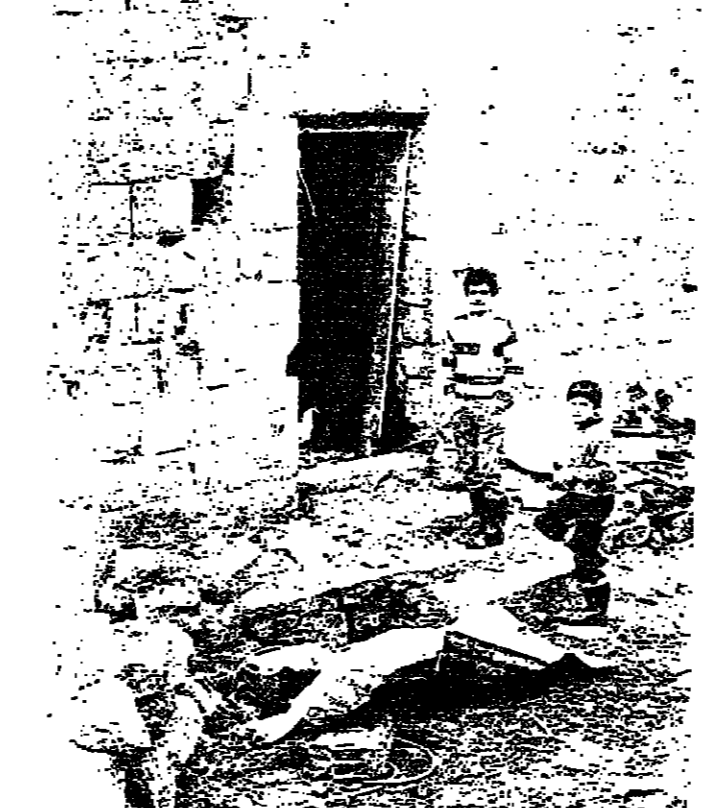
اطفال امام منزلهم الذي لم يسلم من القصف في بلدة ابو تمة
